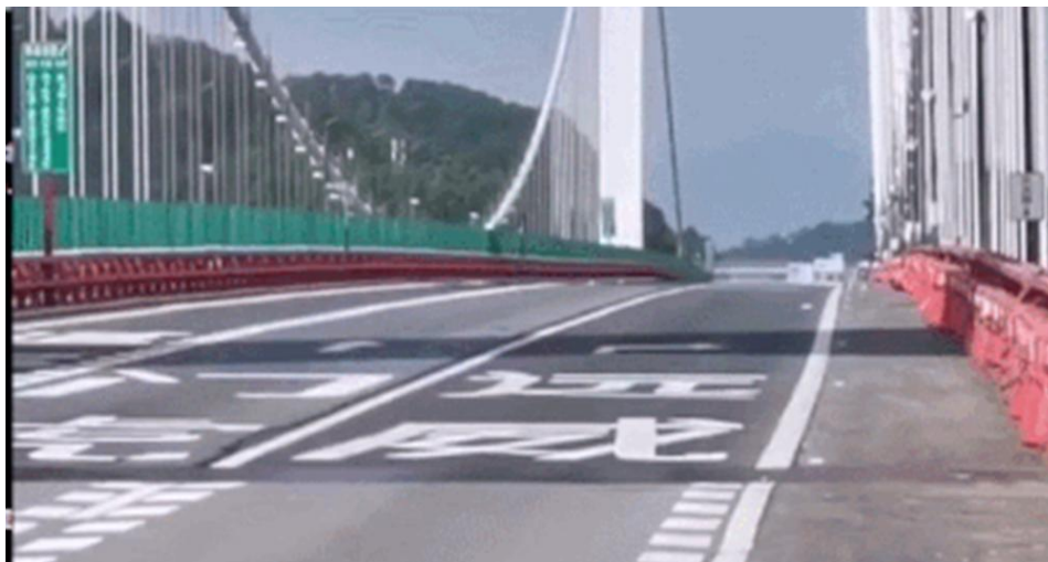
图 1 2020 年 5 月 5 日广东虎门大桥波浪振动
